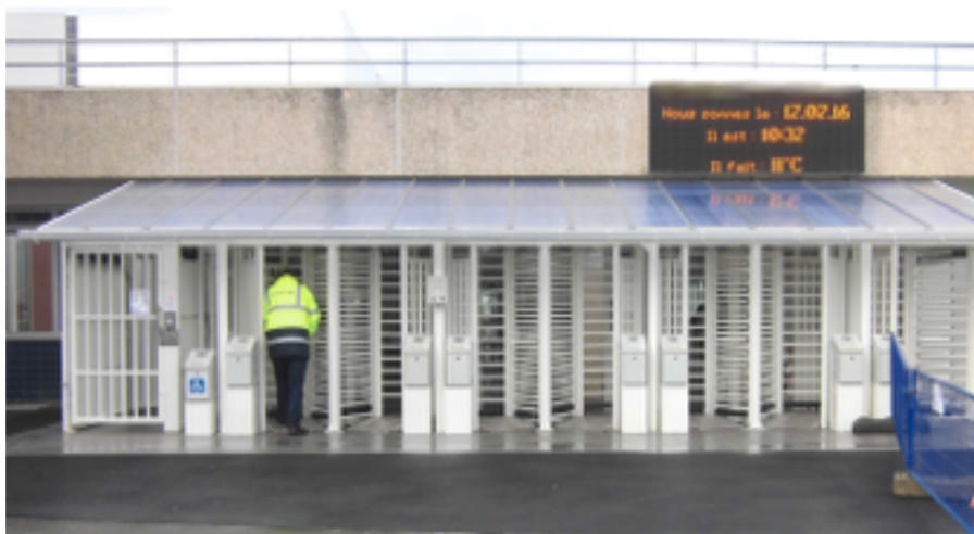
Auvent de protection spécifique Post-réalisation 2015 >
